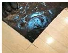
フローリングの床下
